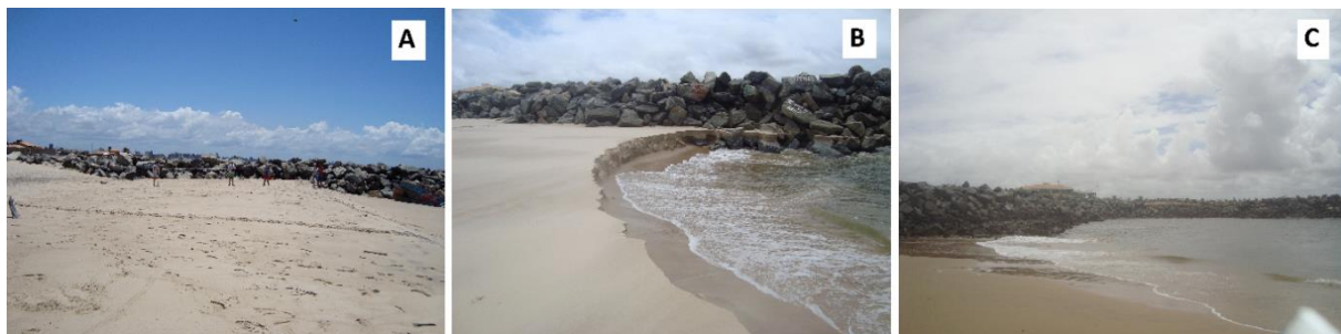
Figura 2. Mudanças na morfologia da Praia dos Artistas, Aracaju, Sergipe. (A) em 2009: praia extensa com berma; (B) em 2010: praia em erosão com escarpa (C) em 2013: ausência de praia. Fonte das fotografias: acervo de projeto de pesquisa.
